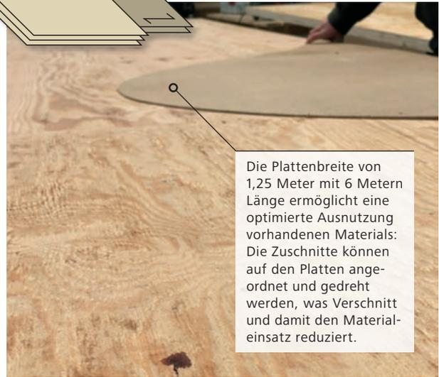
Die Plattenbreite von 1,25 Metern mit 6 Metern Länge ermöglicht eine optimierte Ausnutzung vorhandenen Materials: Die Zuschnitte können auf den Platten angeordnet und gedreht werden, was Verschnitt und damit den Materialeinsatz reduziert.
